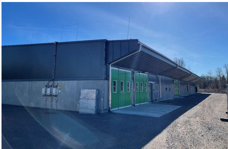
Figur 10 Det nya reningsverket i Figeholm
