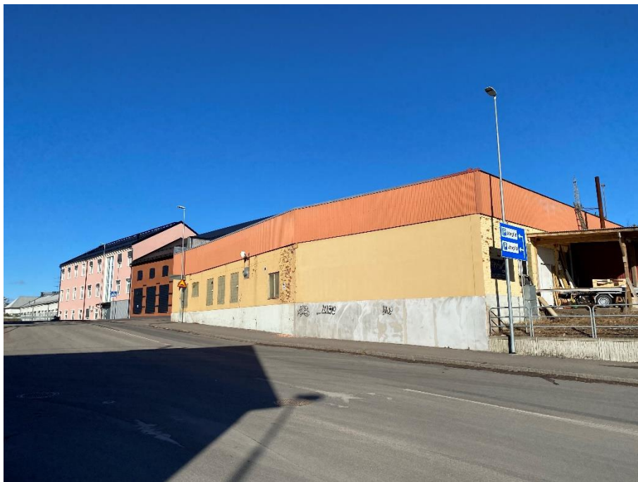
Befintlig verksamhetsbyggnad inom planområdet. Byggnaden är sammanbyggd med den bruna och rosa byggnaden i bakgrunden som ryms inom fastighet Torrdockan 1.
